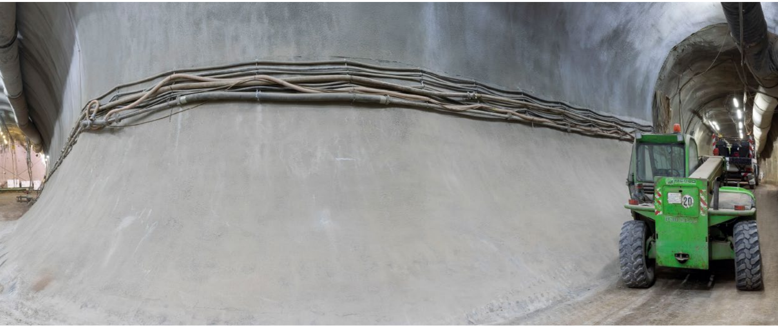
Schachtanlage Konrad: Streckenkreuz an der Vordreheranlage, 2. Sohle
