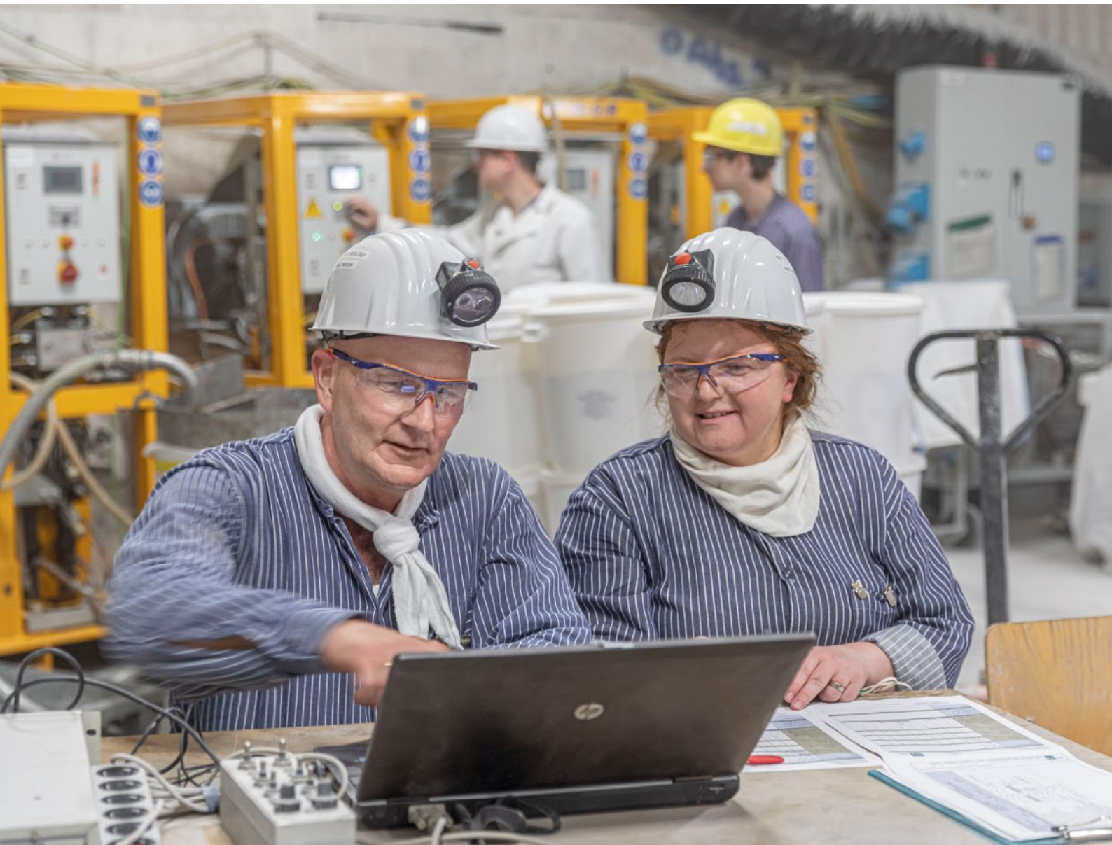
Schachtanlage Asse: Injektionsarbeiten – Abstimmung der Injektionsparameter für die Abdichtinjektionen an der Strömungsbarriere SB-750-7 (750-m-Sohle) mit einem partikelgestützten Injektionsmedium, Horst Mentzel und Astrid Hofschlag (BGE TECHNOLOGY GmbH)
